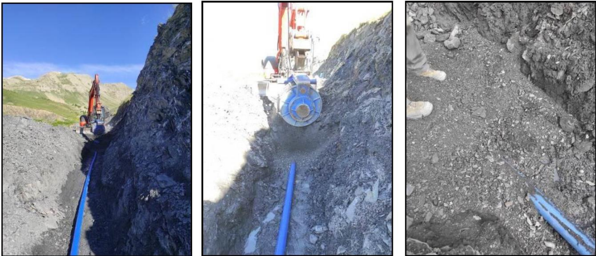
Photo 5 : travaux de pose de conduite et remblaiement en matériaux cribblés
