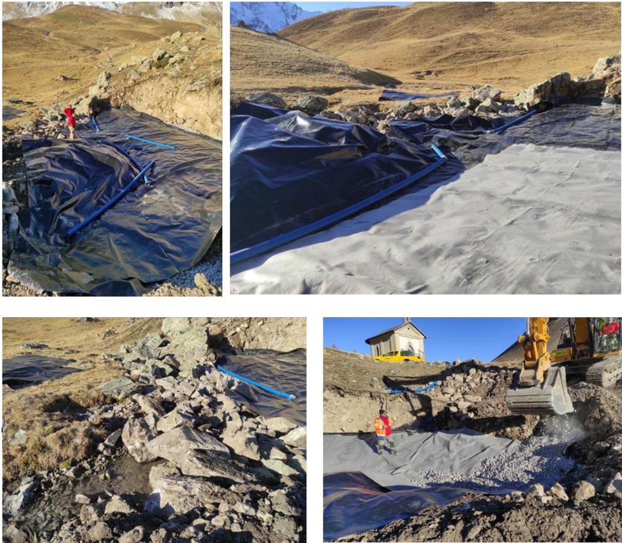
Photo 8 : remblaiement du site au-dessus de la tranchée drainante (19/00/2020)
