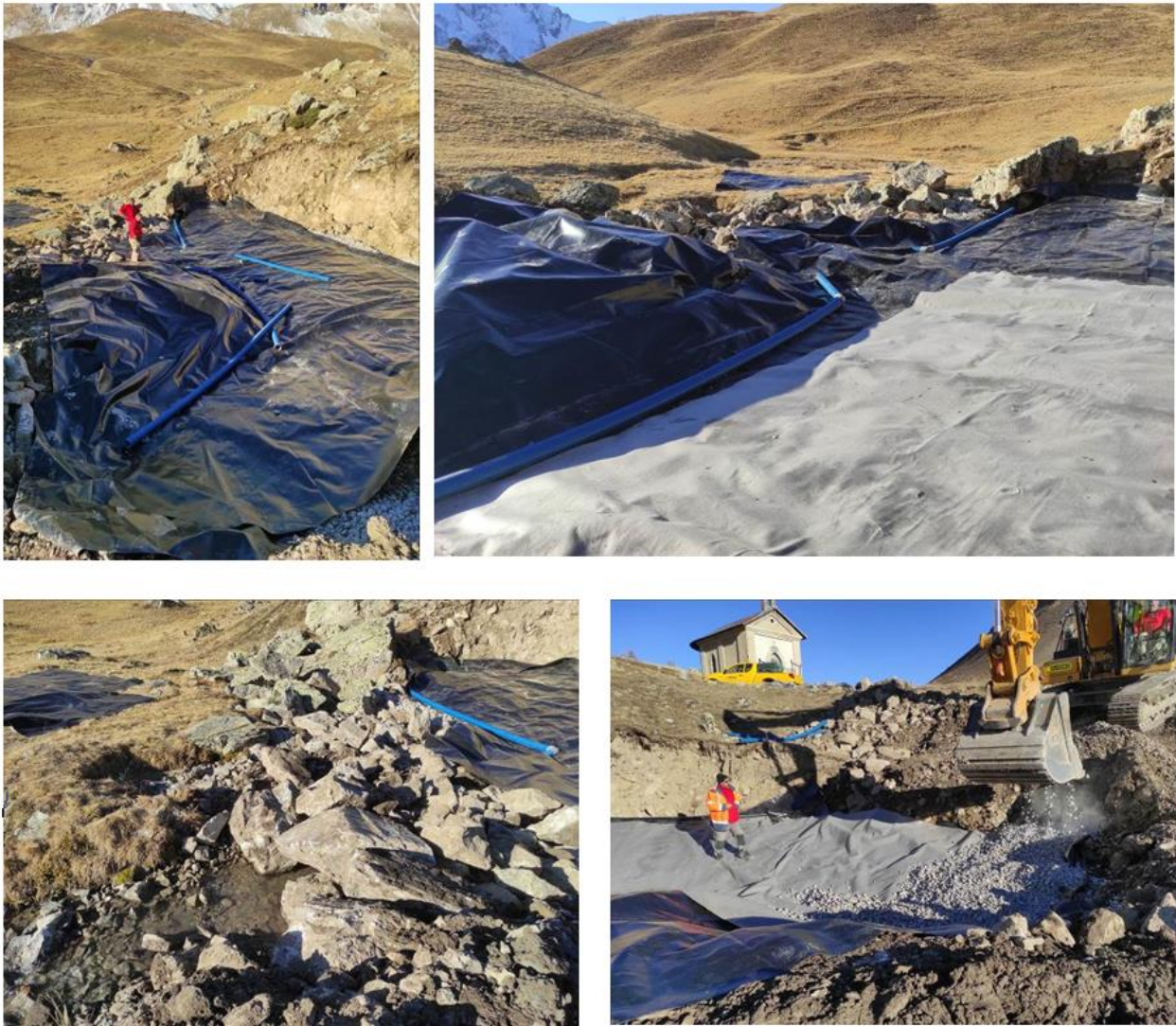
Photo 3 : remblaiement du site au-dessus de la tranchée drainante (19/00/2020)
