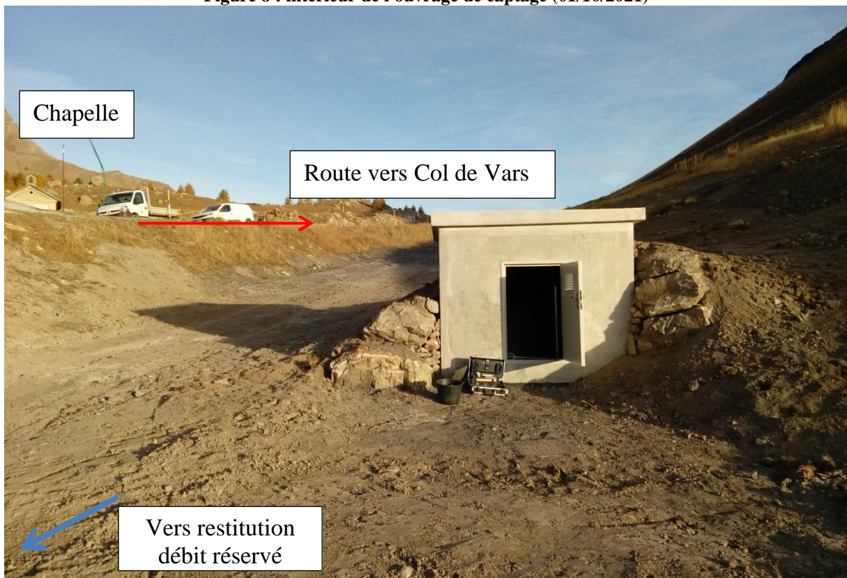
Photo 4 : ouvrage de captage vu depuis l'extérieur (19/10/2021)
